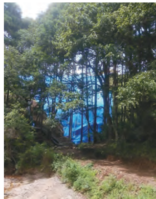
ザク沢地区の工事現場の高さ20mの土壁
