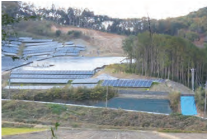
本戸不動産の太陽光発電設備
