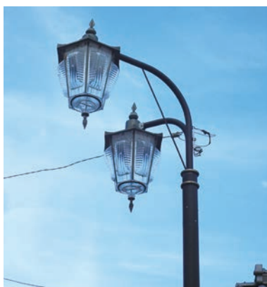
古い街路灯を撤去します
