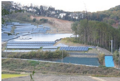
本戸不動産の太陽光発電設備
