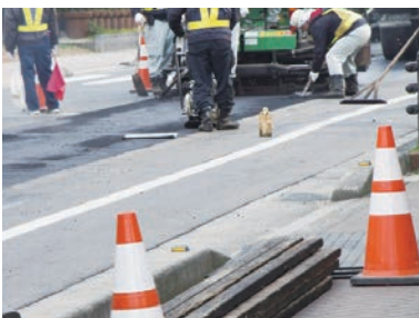
傷んだ箇所は早めに補修を！
