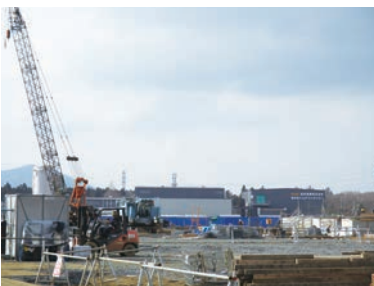
進出企業の工事状況
