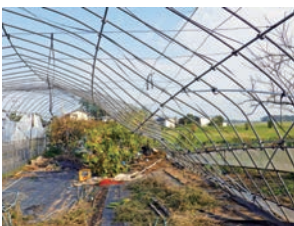
台風被害をうけたパイプハウス
