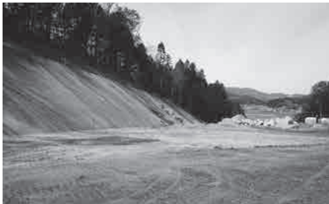
建設工事が進められる来栖本戸線
