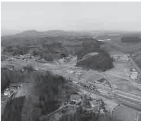
道の駅建設予定地（手越地内）
