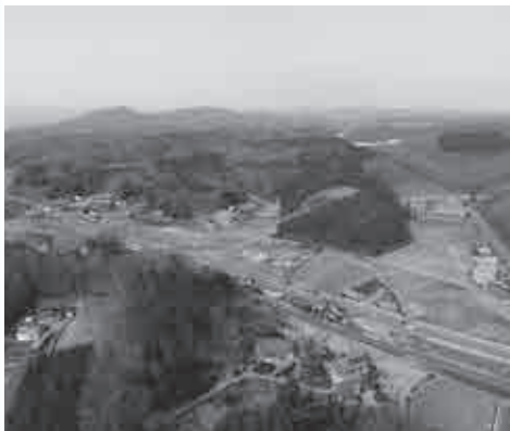
道の駅建設予定地（手越地内）
