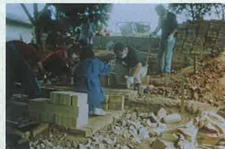
被災した登り窯の復旧作業の様子
