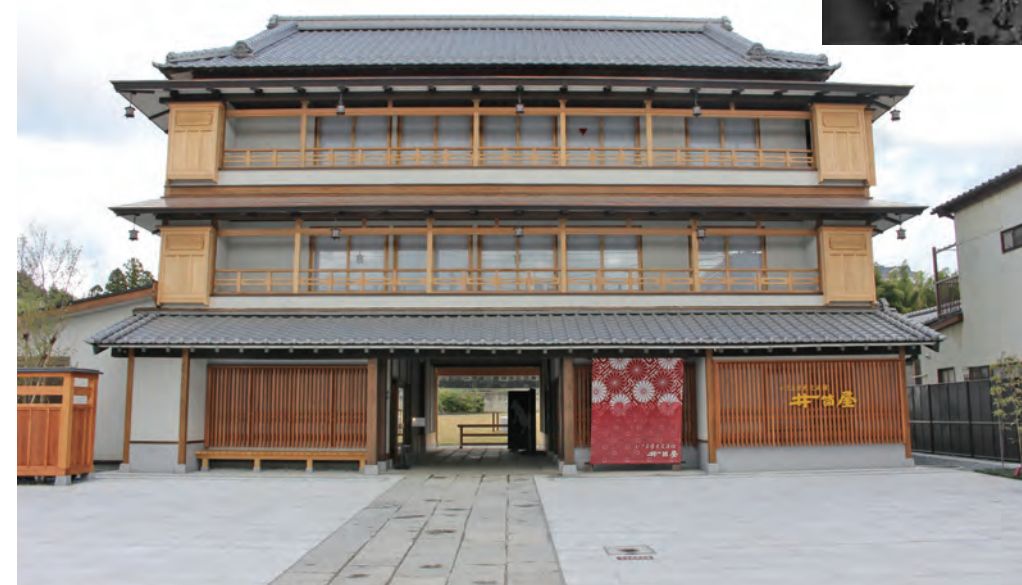
旧井筒屋の面影を残す外観。建物前方の交流広場はイベント開催時に重宝されています
