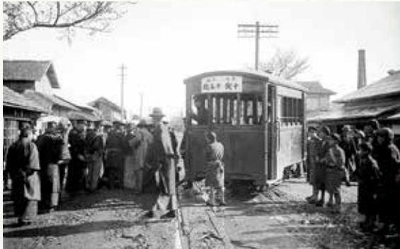
大正14年に起きたガソリン機関車の脱線事故の様子
