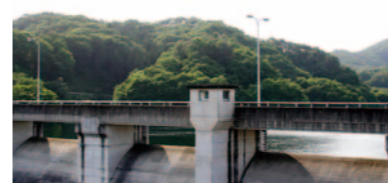
重力式コンクリートダムの飯田ダムは、高さ33メートル。下流域の水害を防除したり、農地用水などに利用されます。
