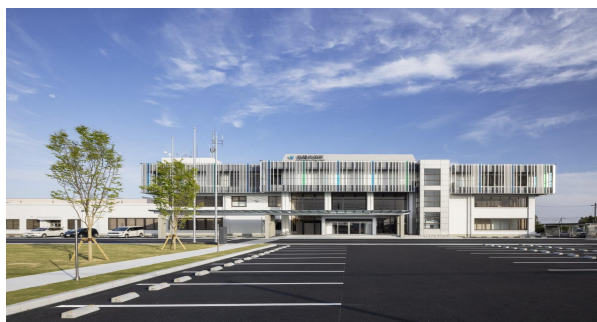
本庁舎大規模改修
