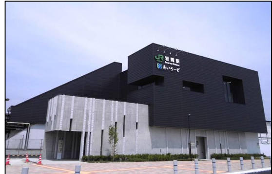
岩間駅周辺整備
