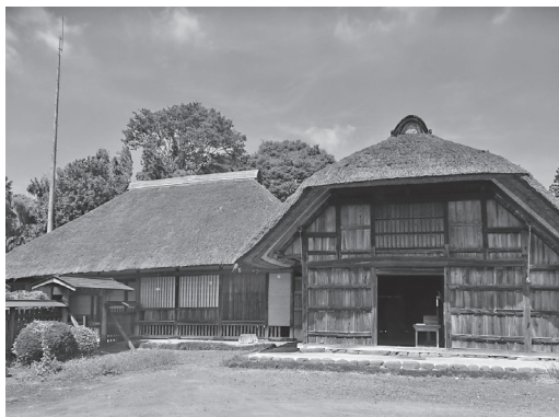
塙家住宅 外観
