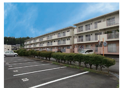
給排水管工事を実施する市営石崎住宅
