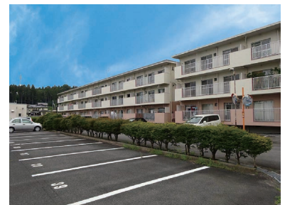
給排水管工事を実施する市営石崎住宅
