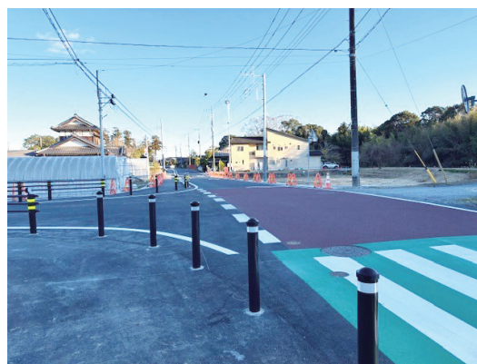
歩道が整備された道路（穴戸地内）
