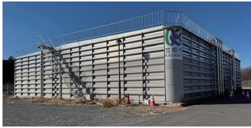
新穴戸浄水場（配水池）
