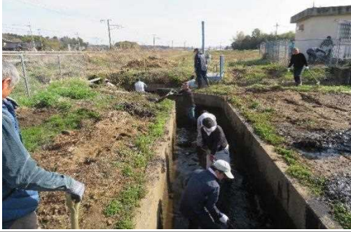
【時期】4月 【内容】通水前の機場水路土砂上げ清掃及びポンプ点検
