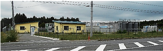
日夜稼働して、市民のいのちと暮らしを支えている笠間市穴戸浄水場
