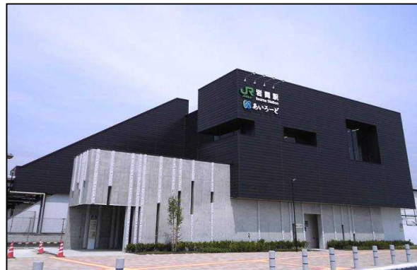
岩間駅周辺整備
