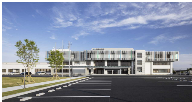
本庁舎大規模改修
