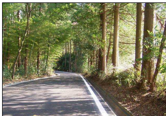
舗装された林道本戸前山線
