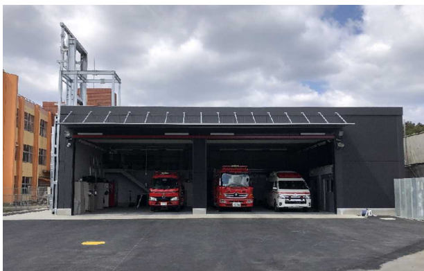
岩間消防署（車庫棟）
