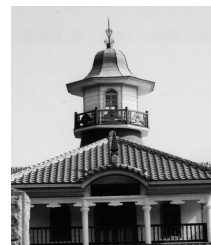
水海道小学校旧校舎(部分)
