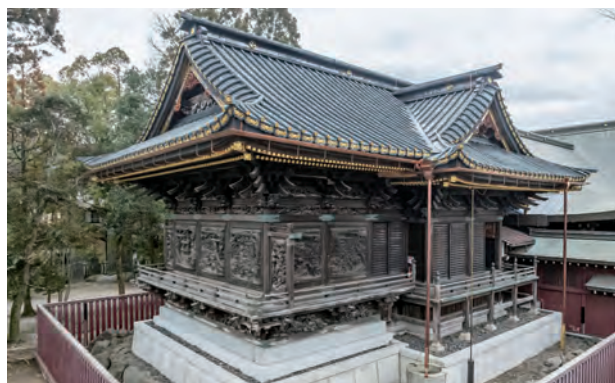
保存修理工事が完了した笠間稲荷神社本殿
