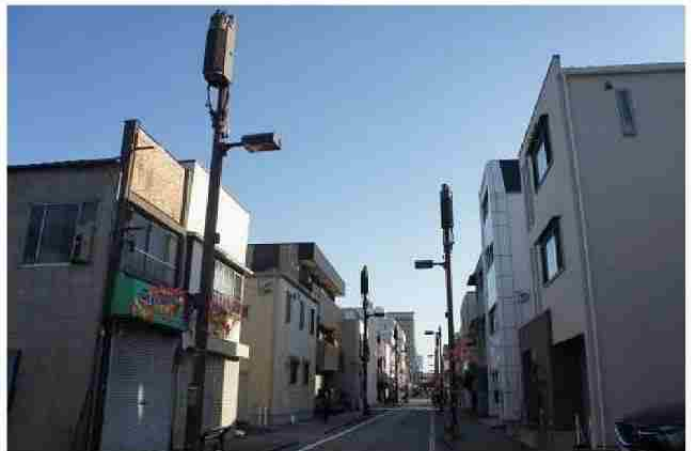
（街路灯との共用柱にトランスを設置した例（ソフト地中化））
