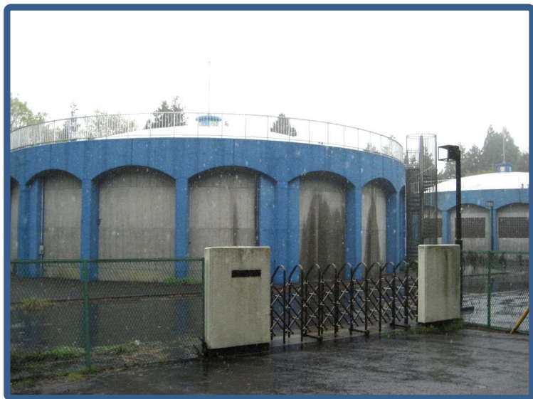
箱田配水池 【P C造 2,500m 3 ×2基】
