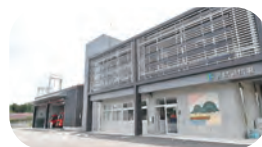
岩間消防署新庁舎
