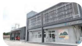
岩間消防署新庁舎
