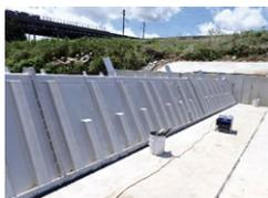
造成後50年が経過しており老朽化により鋼製転倒堰から従来よりメンテナンス費用のかからないステンレス製転倒堰に更新しました。現在ゲートは一部の配管を残して工事完了しており、5月末までには仮設道路等を撤去し完了を見込んでおります。5月時点では仮設を利用し河川堰止め取水しておりますが、6月以降は新しい堰により取水を見込んでおります。\*万が一、悪天候等により工期が延長された場合は、取水に影響の無いよう対応いたしますのでご理解のほどをお願い申し上げます。
