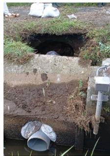
鉄管が腐食したため穴戸地区環境保全会の協力で応急補修。
