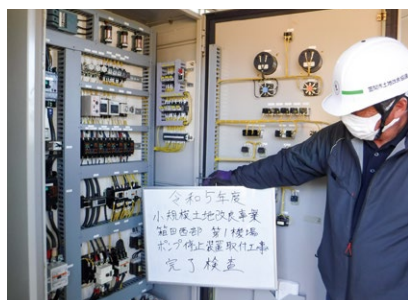
小規模土地改良事業 箱田西部地区 （第1機場）ポンプ停止装置取付工事
