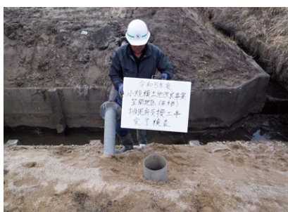
小規模土地改良事業 笠間地区 （来栖）排泥弁交換工事
