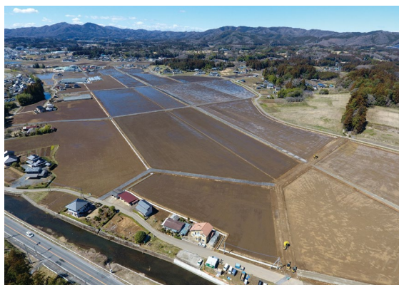
県営土地改良事業 笠間大洲地区 整地工事
