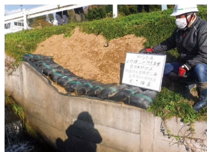
小規模土地改良事業 箱田東部地区 （寺崎）幹線排水路補修工事
