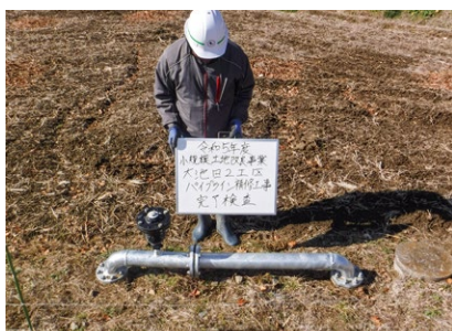
小規模土地改良事業 大池田地区 （2工区）パイプライン補修工事
