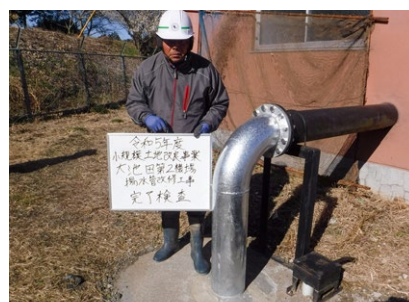
小規模土地改良事業 大池田地区 （第2機場）揚水管改修工事
