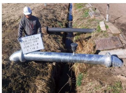
小規模土地改良事業 笠間地区 （来栖）水管橋改修工事
