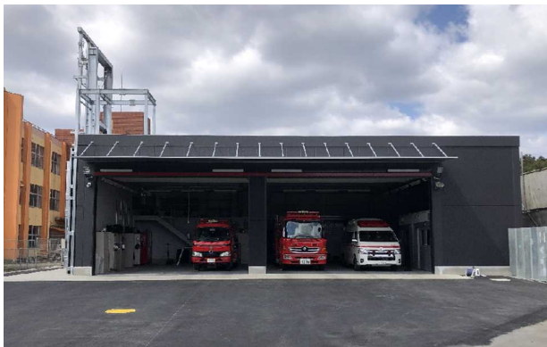
岩間消防署（車庫棟）
