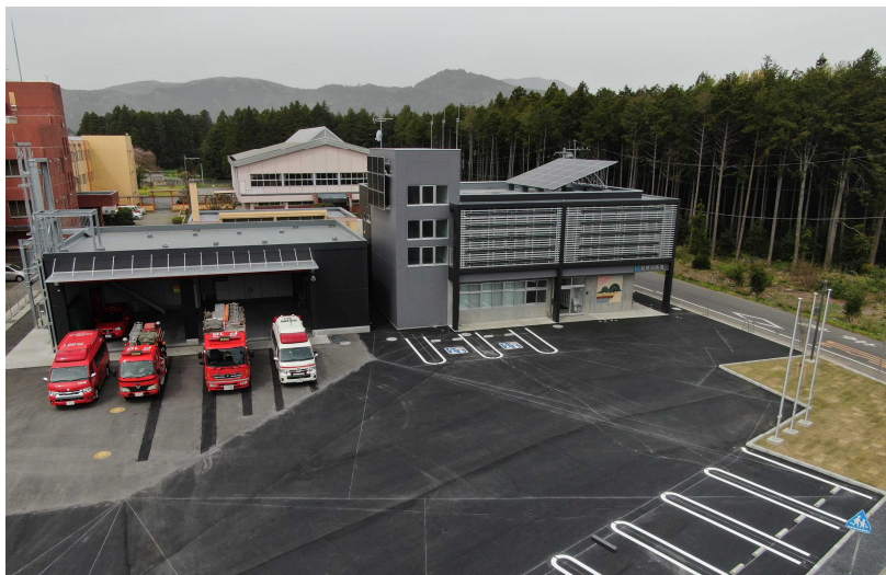
岩間消防署新庁舎
