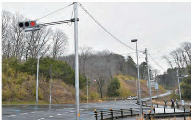
設置された信号機
