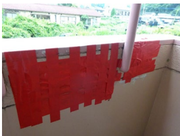
手すり壁 C
