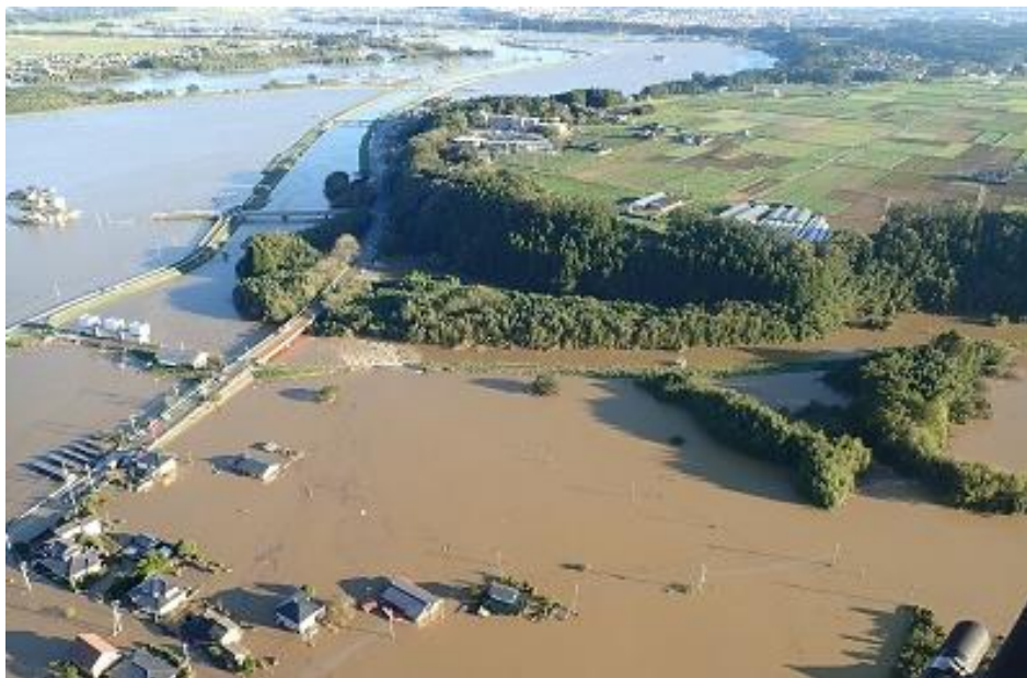
令和元年東日本台風(台風第19号)による水害 (出典:茨城県HPより 県広報紙「ひばり」2020(令和2)年7月号掲載写真)
