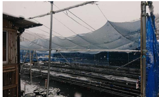
2022(令和4)年3月降雪・降雹により、菊栽培所の防風ネットと支柱が損壊 (提供:笠間市 農政課)
