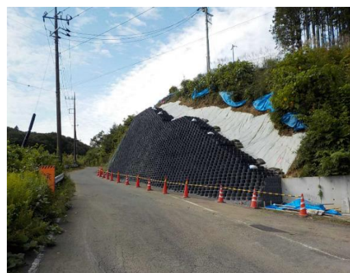
復旧状況 (提供:笠間市 建設課)
