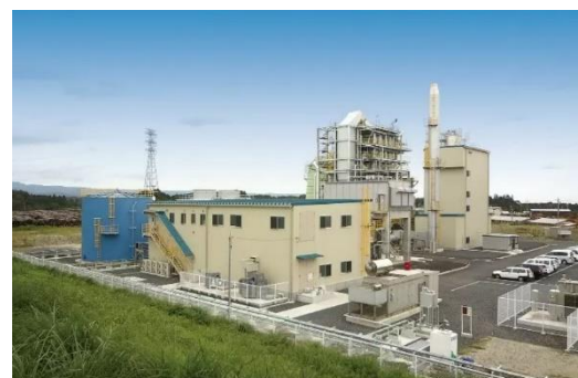
笠間市近隣の木質系バイオマス発電所 (出典：日立造船株式会社 宮の郷バイオマス発電所)
