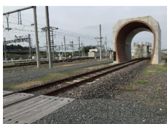
▲模擬トンネル
