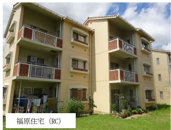
< 築年次が新しい住棟 >
