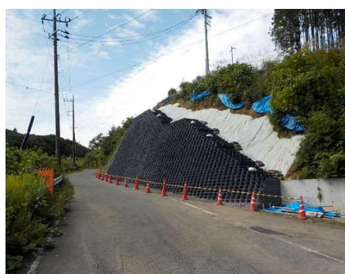
復旧状況 (提供:笠間市 建設課)
