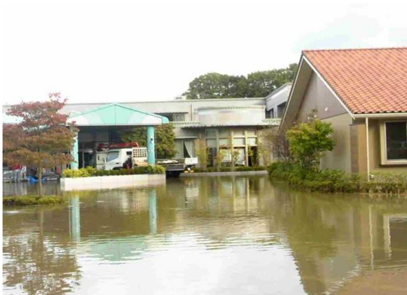
2014(平成26)年の台風18号による浸水被害 (提供:笠間市 危機管理課)
