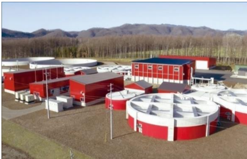
メタン発酵バイオマス発電 (出典:北海道河東郡鹿追町)
