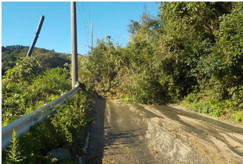
2019(令和元)年の台風19号による土砂崩れの現場 (提供:笠間市 建設課)
