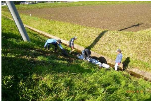
【時期】4月9日 【内容】水路泥上げ作業後に第4機場エリアの法面陥没箇所(10か所)に土のう袋による補修作業。
