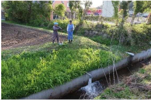
【時期】 4月 【内容】 施設の点検、機能診断を実施しました。
