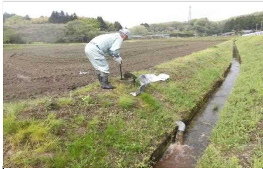
【時期】4月・9月 【内容】 パイプラインの泥抜きを春と秋の年2回行っている。
