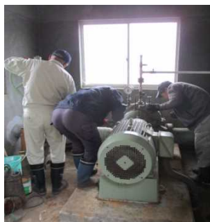
【時期】 4月 【内容】 かんがい期前の機場ポンプ、補助ポンプや付帯施設の点検・注油・清掃及び通水試験を実施した。
