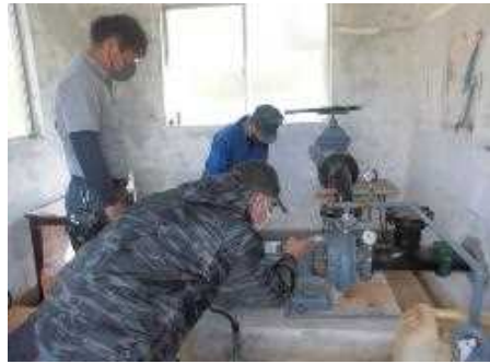
【時期】4月 【内容】ポンプの点検、グリスアップの実施
