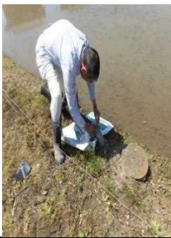
【時期】5月 【内容】 パイプラインの一部が劣化し、ピンホールが発生した為その補修をする。
