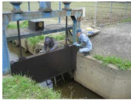
【時期】令和5年4月 【内容】水門錆取り塗装
