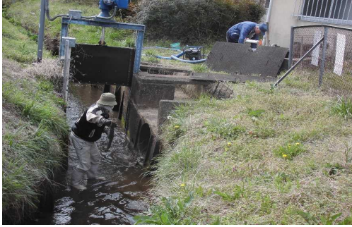
【時期】令和5年4月 【内容】第一機場、第二機場の点検、送水テスト、取水槽の泥払い清掃
