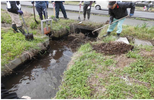
【時期】令和5年4月 【内容】地権者による水路の泥払い、水路全域の泥払いと分岐堰、U字溝の堆積物除去、一部草刈り実施
