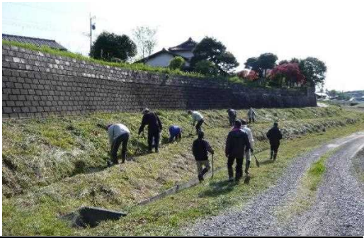
【時期】令和5年4月23日 【内容】水路の泥上げ及び水路の点検
