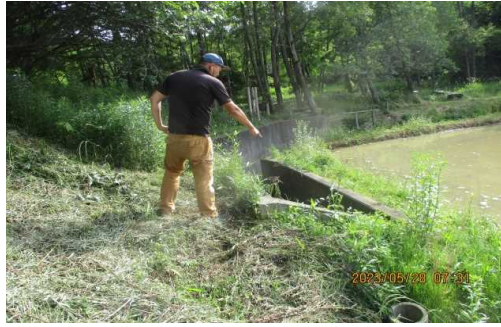
【時期】5月28日 【内容】 水路の点検作業
