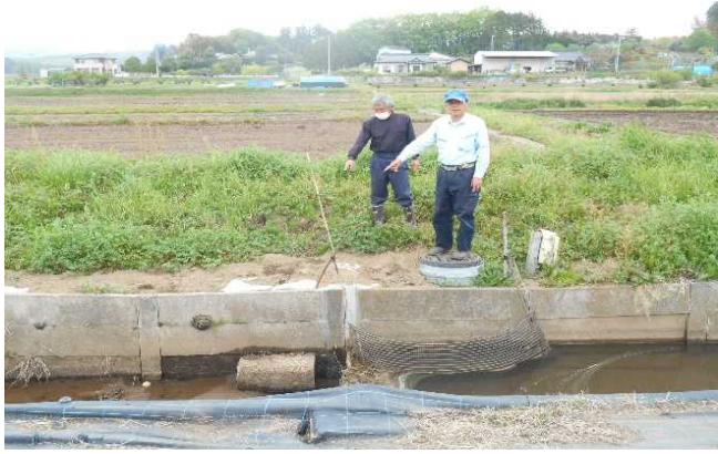
【時期】 4月 【内容】 土手・用水路陥没箇所補修工事（外注工事:株ゴミタ）竣工検査
