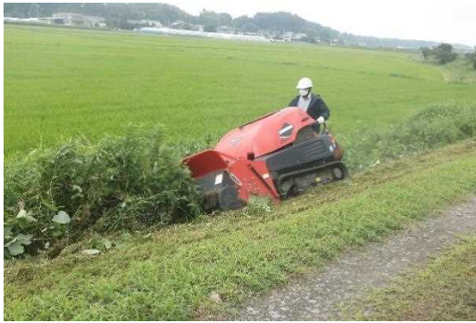
【時期】6月 【内容】大型草刈り機による、農地法面・河川堤防の除草作業
