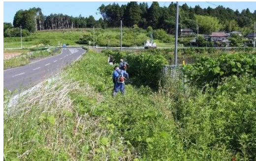
【時期】6月4日 【内容】ため池(3か所)周辺及び、水路法面の草刈り。
