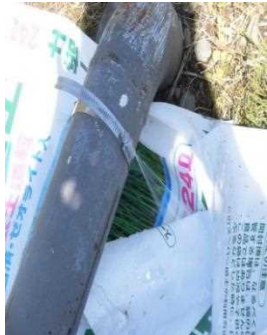
【時期】5月 【内容】 パイプラインの一部が劣化し、ピンホールが発生した為その補修をする。
