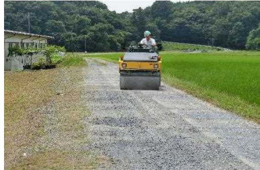
【時期】7月 【内容】農道補修工事
