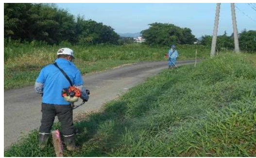
【時期】 5月、7月、8月 【内容】人力により、耕作道路・水路周辺の除草を、年3回行っている。
