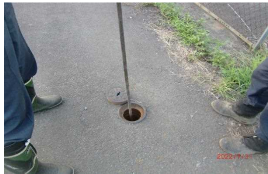
【時期】4月 【内容】送水管の点検作業
