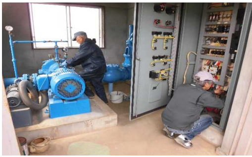
【時期】 令和5年4月 【内容】 春の田植えシーズンに向けて各機場ポンプの修理点検
