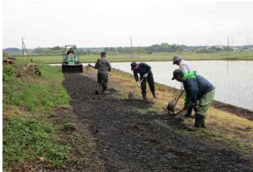
【時期】5月 【内容】水路周辺の点検後、砂利を補充し、整備を行っている。
