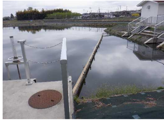
【時期】 4月 【内容】 ため池吸水口のネットを設置した。藻の侵入を防止し、機場管理が円滑に進められた。
