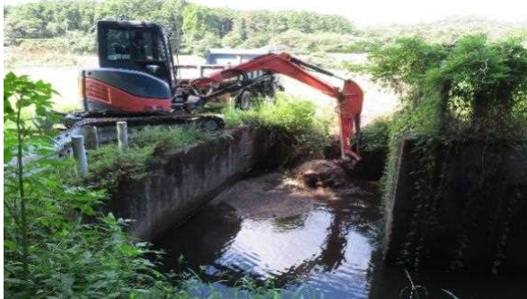
【時期】4月、8月(随時) 【内容】 用水路上流のため池(沈殿槽)、機場用水路の土砂上げを実施。近年堆積量が多くなっている。
