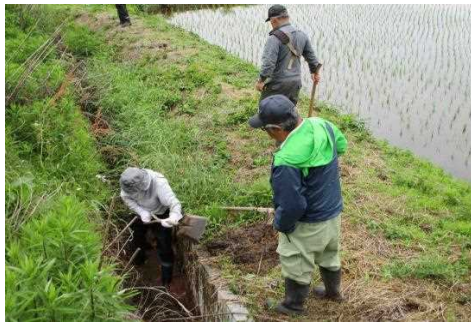
【時期】5月、7月、9月 【内容】水路の点検・泥上げを行っている。
