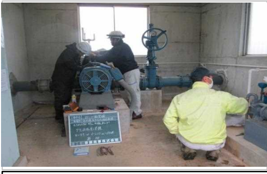
【時期】 4月 【内容】 機場ポンプ等のシーズン前点検
