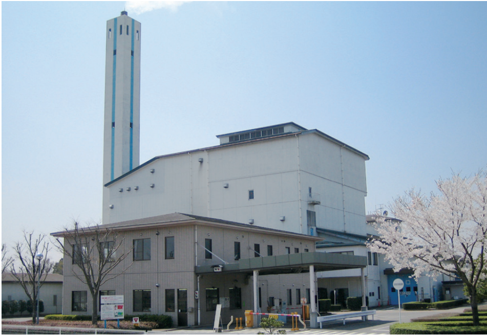
現在のごみ処理施設「笠間市環境センター」
