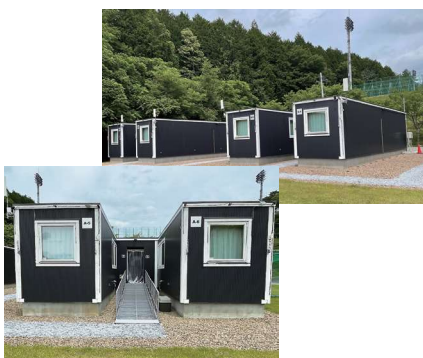
モベリコート岩手(岩手町総合運動公園内)災害時に活用したモバイル型仮設住宅を利用した宿泊施設
