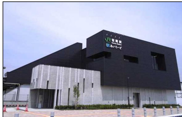
岩間駅周辺整備
