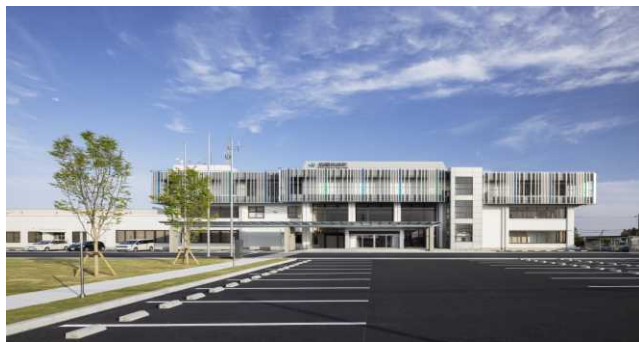
本庁舎大規模改修
