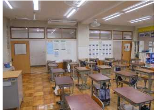
中学校校舎空調設備
