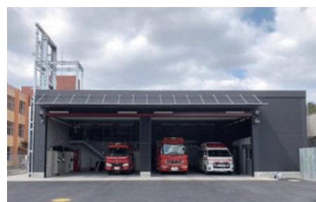
岩間消防署（車庫棟）
