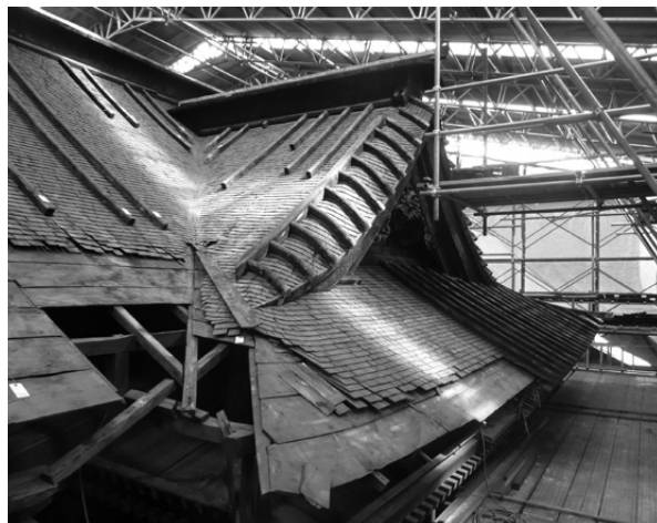
保存修理工事の様子
