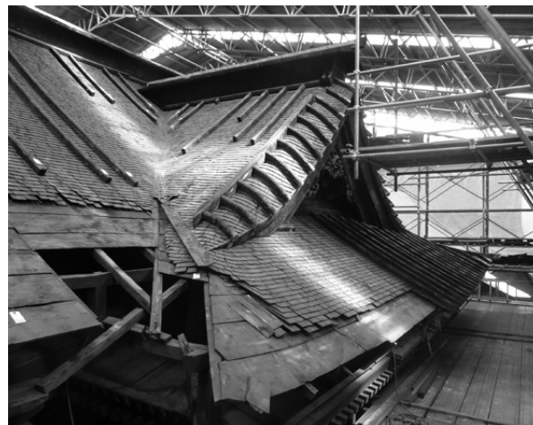
保存修理工事の様子
