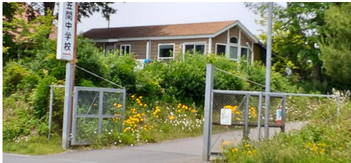
笠間中グランド入口 抜き取り前の様子
