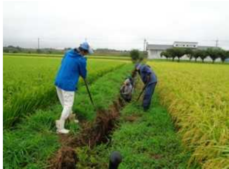
【時期】8月 【内容】水田の落水期を迎え、排水路の泥上げや除草作業を実施した。
