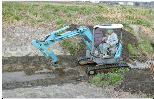
【時期】4月 【内容】土砂撤去工事
