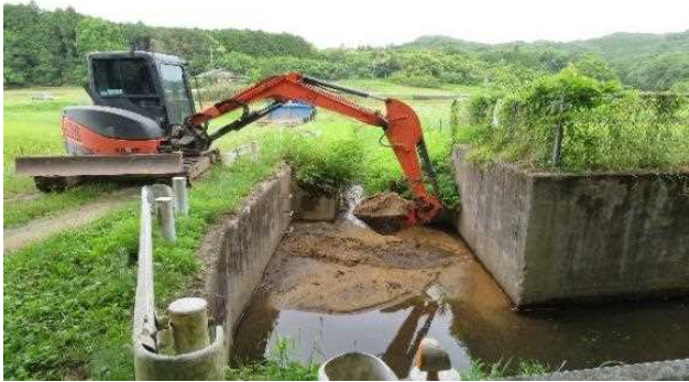
【時期】 4月、6月(随時) 【内容】 用水路上流のため池(沈殿槽)、機場用水路の土砂上げを業者に依頼して実施。
