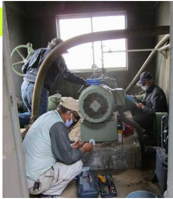
【時期】 4月 【内容】 かんがい期前の機場ポンプ、補助ポンプや付帯施設の点検・注油・清掃及び通水試験を実施した。
