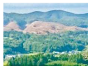
飯田地区太陽光発電所 山林伐採 2021 年
