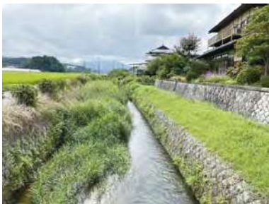
土砂が堆積した稲田川
