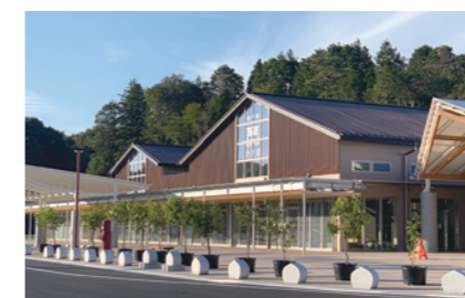
道の駅かさま外観
