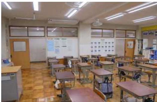
中学校校舎空調設置
