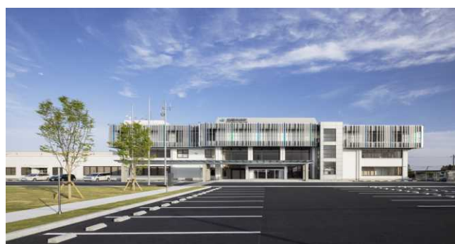
本庁舎大規模改修
