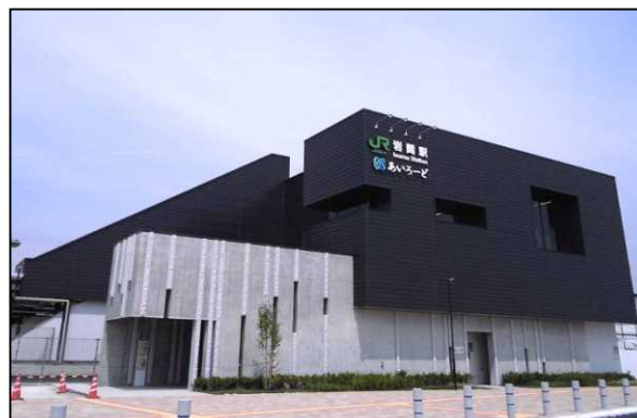
岩間駅周辺整備
