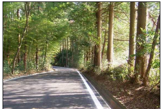
舗装された林道本戸前山線
